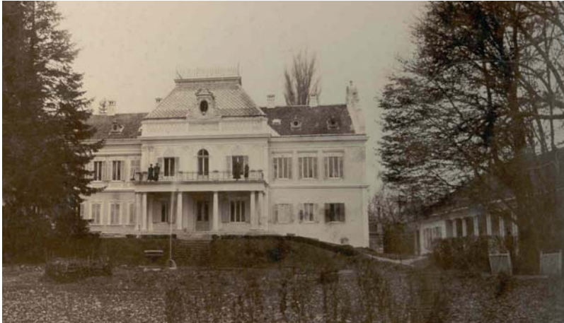
A kastély fő (keleti) homlokzata.
